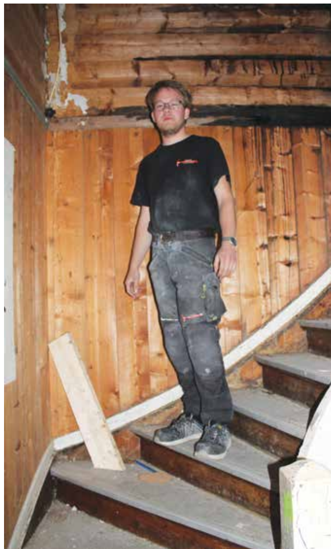
Den originale trappa mellom 1. til 2. etasje skal Mathias Wold ta vare på.
