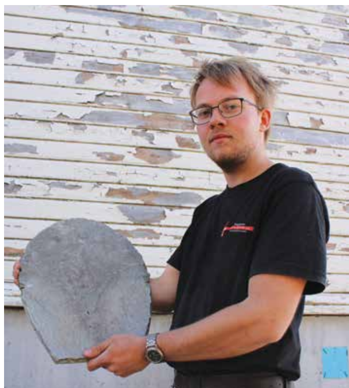
Dråpeskifer var original taktekkning på Elverhøy. Taksteinen har halde seg utruleg godt gjennom vel 100 år, noko som imponerer Mathias Wold.
