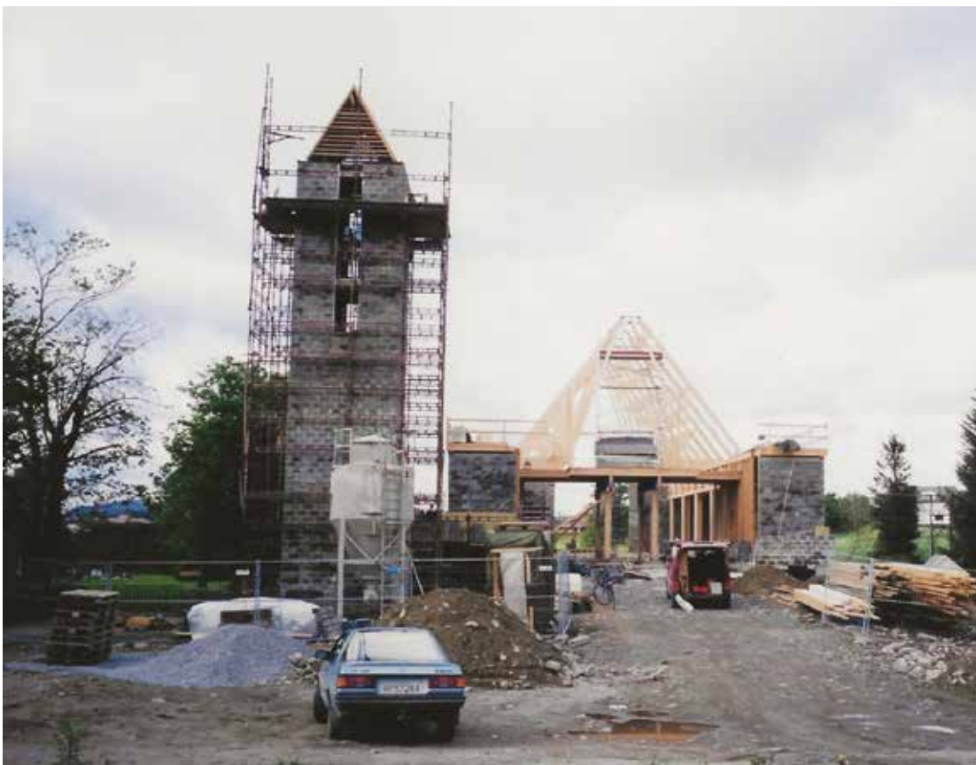
Arbeidet på den nye kyrkja er godt i gang. (Foto: Steinar Sandvik)
